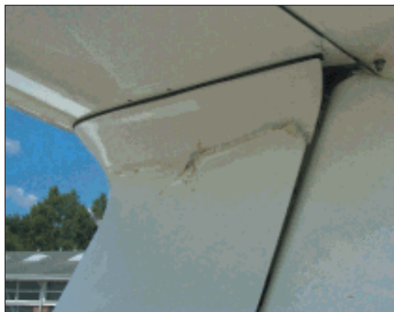
Afb. 12 Schade aan het kielvlak van de PH-1193
